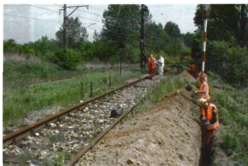
Układanie światłowodów wzdłuż linii kolejowej
